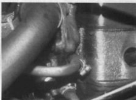
Heizungsanschlüsse für die „BOSCH-Kugel“
